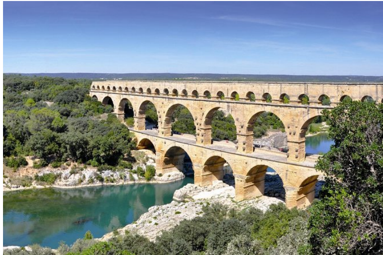
Pont du Gard. Aqueduto romano (275 m de comprimento e 49 m de altura), vale de Gard, sul de França
